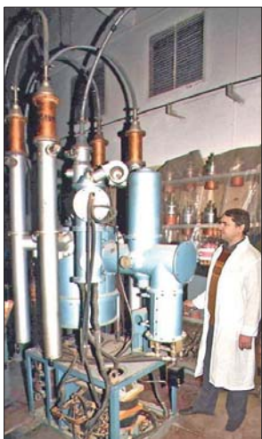
Рис. 9. Генераторный каскад на частоту 297 МГц мощностью 3,5 МВт.
